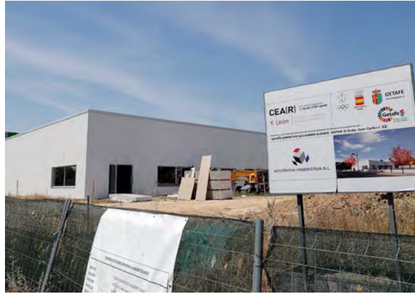
Visita a las obras del Centro Deportivo Alejandro Blanco
