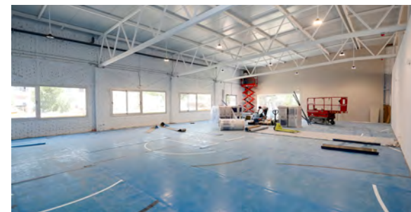
Obras en el gimnasio del Centro Deportivo Alejandro Blanco
