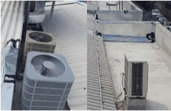
■ Movimiento de dos centrales y un condensador de aire acondicionado para impermeabilizar losa del área ingreso a salas múltiples.
